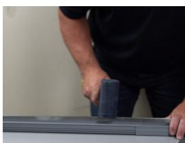
Usando un par de tijeras para cortar metal, primero corte el lado más largo de la moldura del canal en la marca hecha anteriormente. Luego haga un segundo corte a lo largo del lado corto y doble la moldura del canal hacia atrás. Haga un corte final a lo largo de la curva. Lima cualquier borde áspero.
