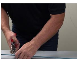
Mida la longitud interior del conjunto y marque la longitud medida en el borde exterior de la moldura del canal.
