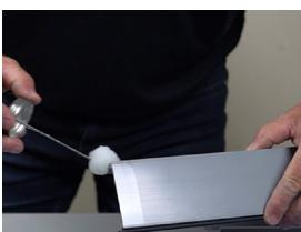
Corte el canal de PVC del tamaño deseado en la ubicación deseada de la sección de salida. Inserte los extremos abiertos del canal de PVC en los extremos ranurados de la sección de salida. Ajuste en seco el canal de PVC y la sección de salida antes de fijarlos. Fije con un imprimador claro de PVC y cemento de PVC.
