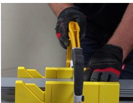
Medir la longitud deseada a pared a pared, permitir el espesor de la baldosa pared y 3/16" por ambas partes. Corte canal a la deseada longitud.
